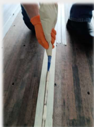
Aplicación de Crack Filler
